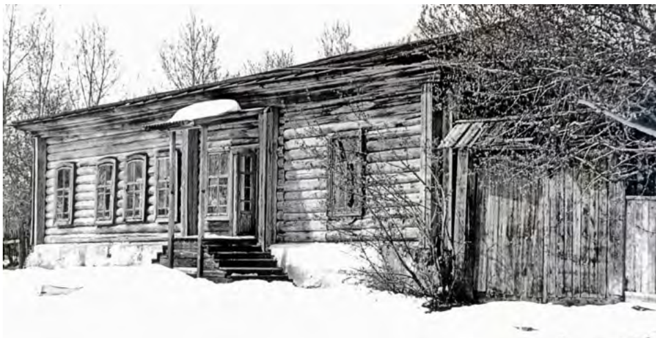
Здание СЮН по адресу К.Маркса, 17 с 1975 по 1992 гг
