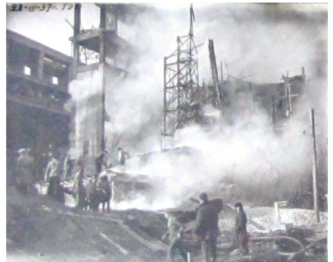
Пожар на ТЭЦ. 1937 г.
